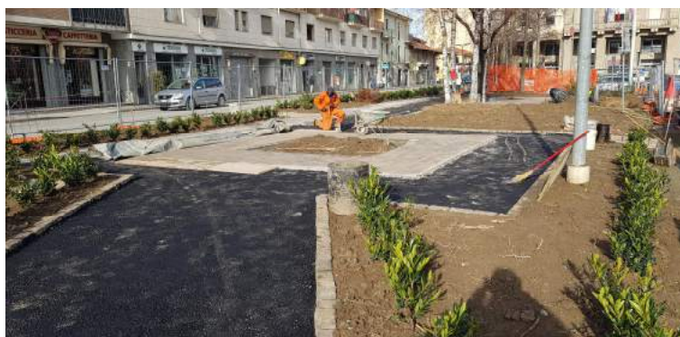
Intervento di riqualificazione degli spazi urbani di piazza Martiri della Libertà - PRIMO LOTTO (in corso di completamento).
