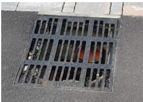
Caditoia per la raccolta delle acque meteoriche.
