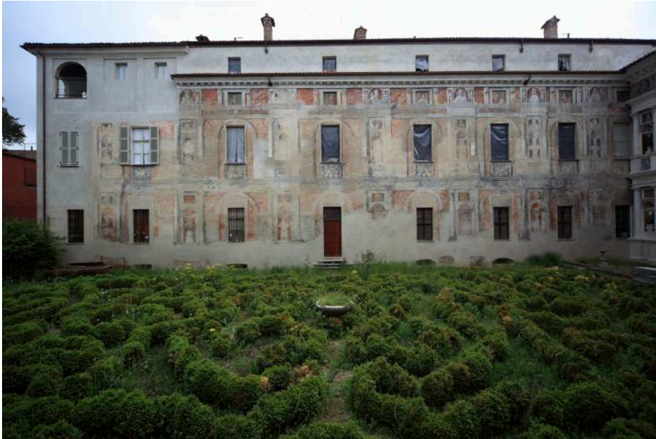
Prospetto ovest dopo l'intervento
