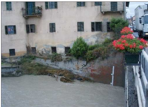
Savigliano, 3 giugno 2008, foto scattata dal ponte di via Alba. A sinistra dell'immagine è ancora evidente, sul muro della casa di Borgo Marene, il livello dell'acqua raggiunto durante la piena del torrente Mellea avvenuta nella notte tra il 29 e 30 maggio 2008
