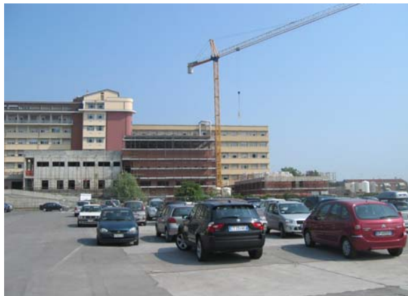
La struttura ospedaliera e il grande parcheggio
