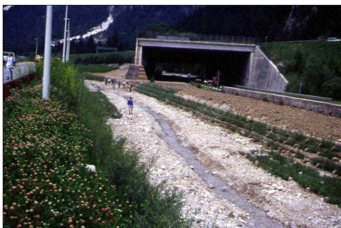
Foto 6 - Fiume Fella post – operam; riassetto morfologico dell'alveo del F. Fella previa demolizione sponde in calcestruzzo e realizzazione di palificate vive spondali a parete doppia e massi legati al piede, terre verdi rinforzate, materassi tipo Reno rinverditi, scogliere rinverdite, copertura diffusa, traverse vive di ramaglia a strati, messa a dimora di talee, arbusti e alberi e idrosemina, giugno 2001 – Foto G. Sauli
