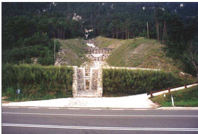
Foto 2 - Rio Anonimo (Tarvisio - UD), post operam 2002: briglie vive e terre rinforzate verdi - Foto G. Sauli
