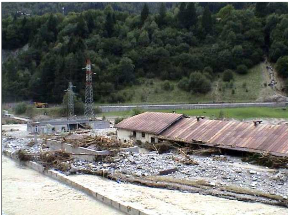
Deposizione di vegetali per rigurgito di correnti di piena in area di confluenza
