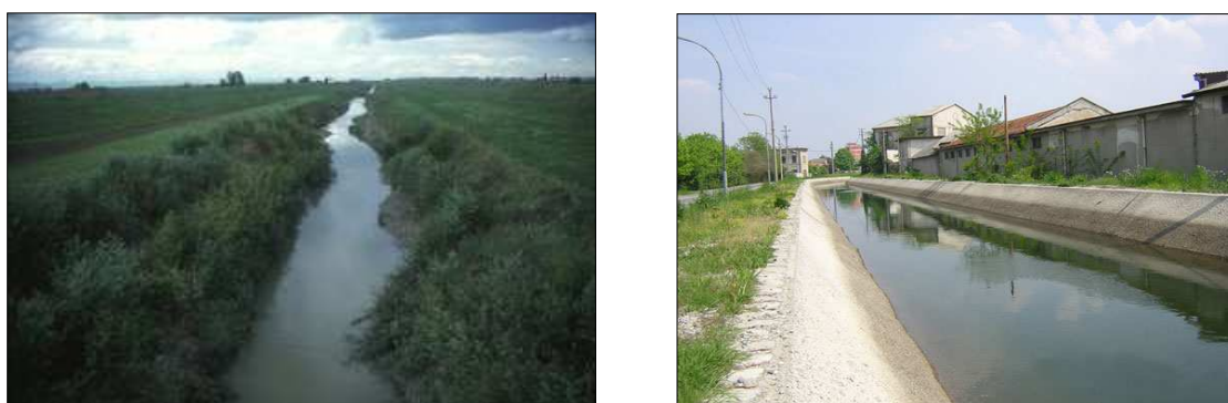
Fig. 1 - canali irrigui: naturaliforme (a sinistra) e cementificato (a destra)
