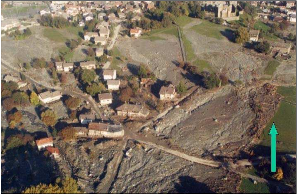
Ammasso di tronchi di conifere in margine a zona di deposito di una colata detritica torrentizia
