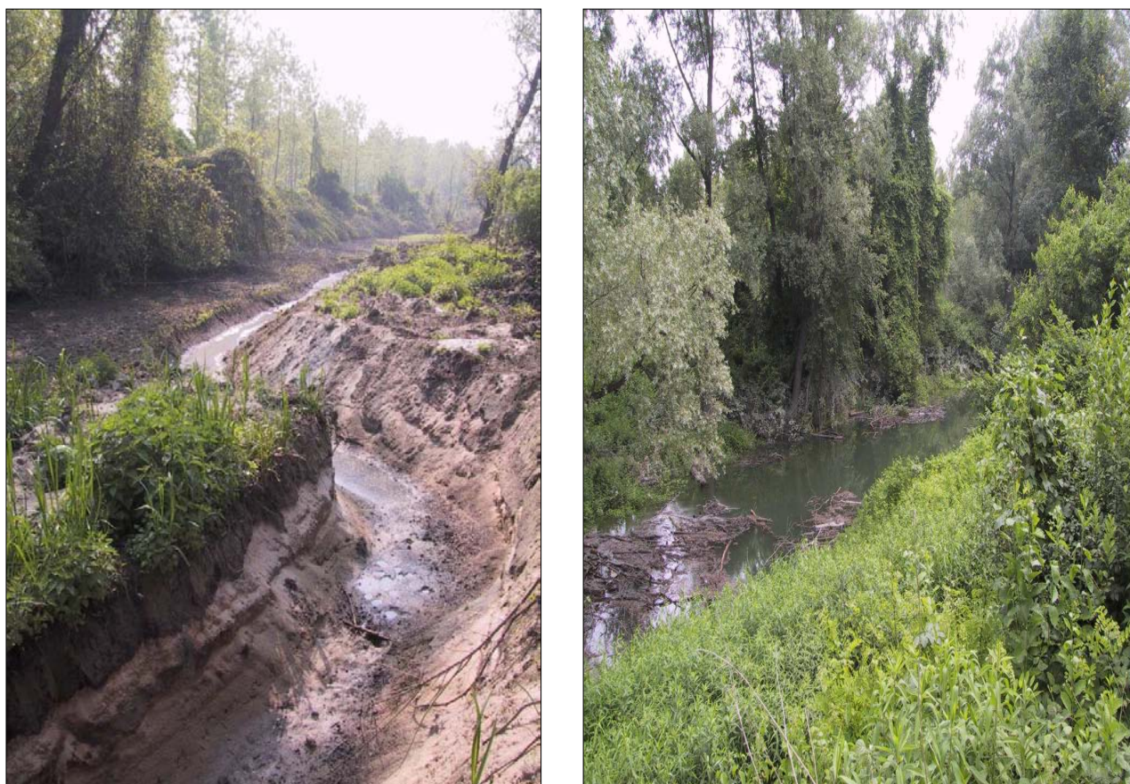
Fig. 4 Il colatore Gravellone Vecchio (Pavia) prima e dopo gli interventi di riqualificazione
