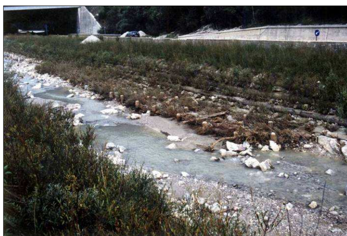
Foto 7 - Fiume Fella, resistenza delle opere post alluvione 29 agosto 2003 – Foto G. Sauli
