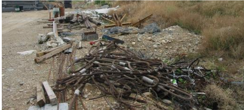
Figura 13. Cumuli di materiale e di residui di lavorazione.
