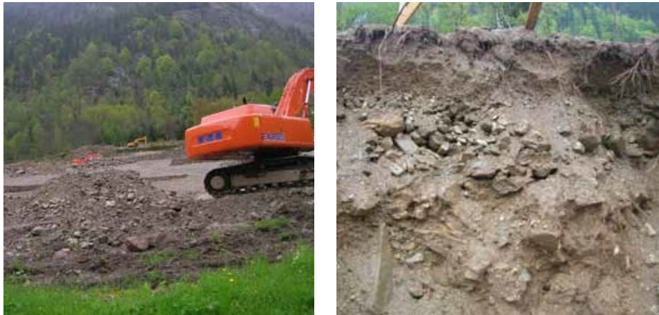
Figura 6-7. Fasi di lavoro del cantiere, a sinistra opere di sbancamento e creazione dei cumuli, a destra, scavo e asportazione dell'orizzonte più superficiale (colore più scuro) (Bassignana et al. 2011, modificato).
