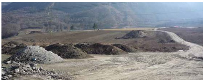
Figura 8. Separazione in cumuli degli orizzonti più superficiali e di quelli più profondi (Bassignana et al. 2011, modificato).
