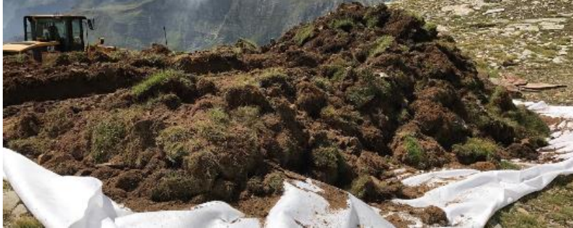
Figura 9. Stesura di un telo protettivo alla base del cumulo.
